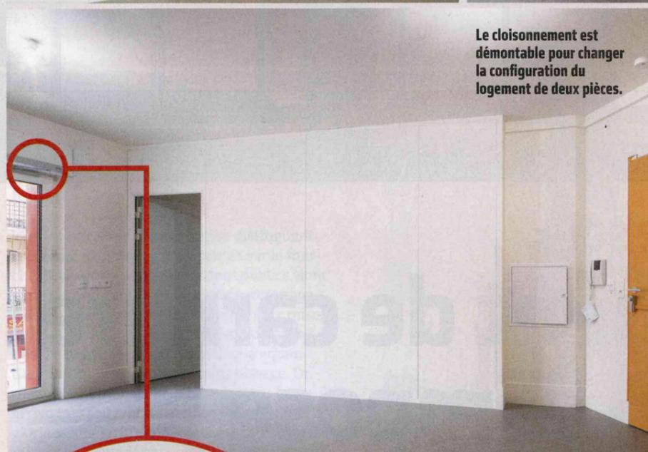
Le cloisonnement est démontable pour changer la configuration du logement de deux pièces.
