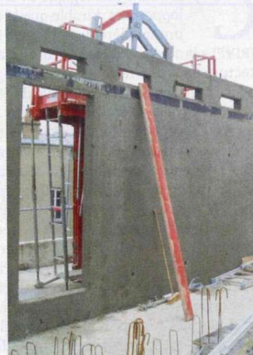
Les balcons sont coulés en place sur des consoles en acier fixées sur le voile façade. Un isolant extérieur coupe-feu, positionné au droit des balcons, évitera la propagation d'un éventuel incendie.
