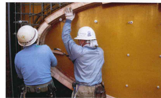
開口型枠の取り付け。
