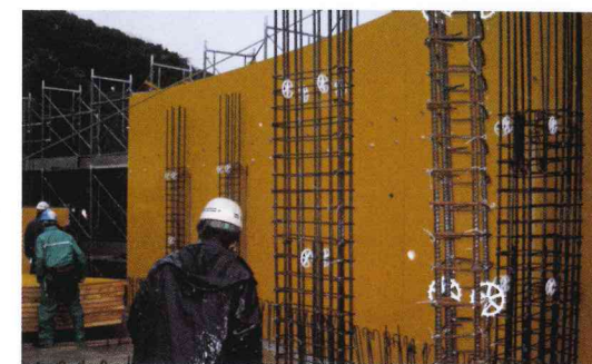
外壁型枠を立てる。
