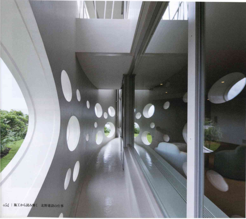
上：外壁を見る。楕円開口の下側に見えるのは水抜きパイプ。 左：テラスと楕円開口を見る。
