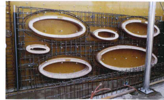
この後、内側の型枠を貼り付け、コンクリートを流し込む。
